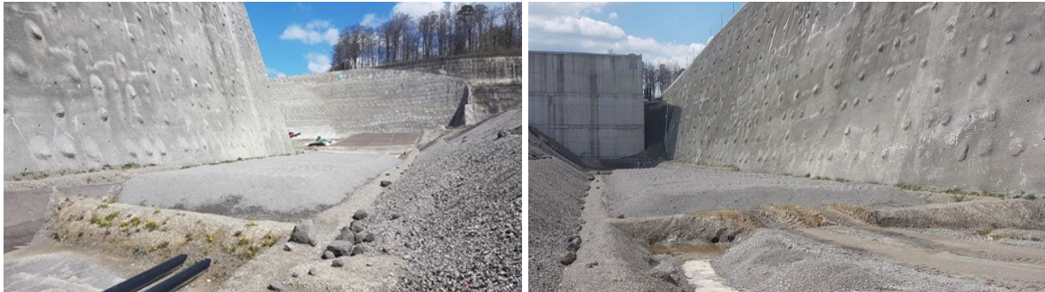
Abb. 3.2: Testkompartiment nach Einbau der zweiten Schlackenschicht.
