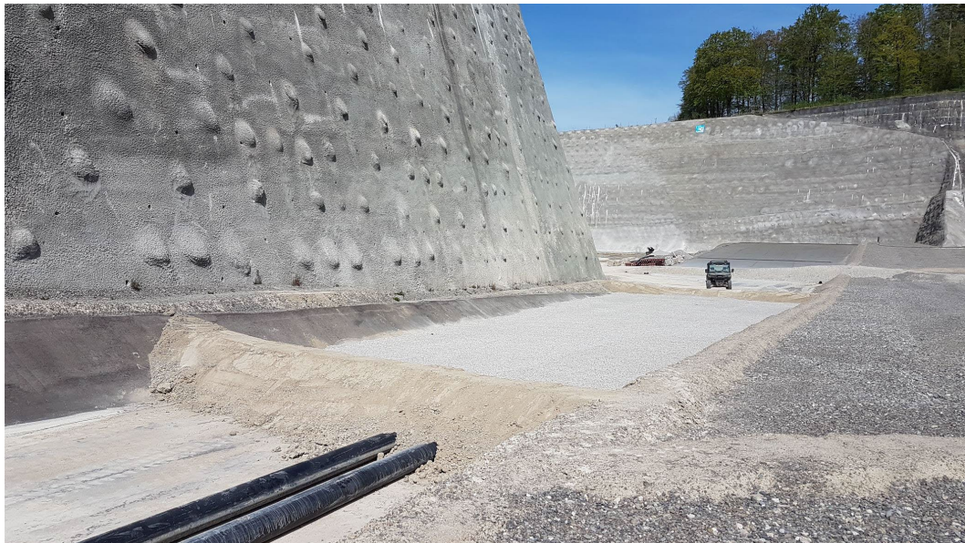
Abb. 3.1: Testkompartiment vor Einbau der Puffer-Schlackenschicht.
