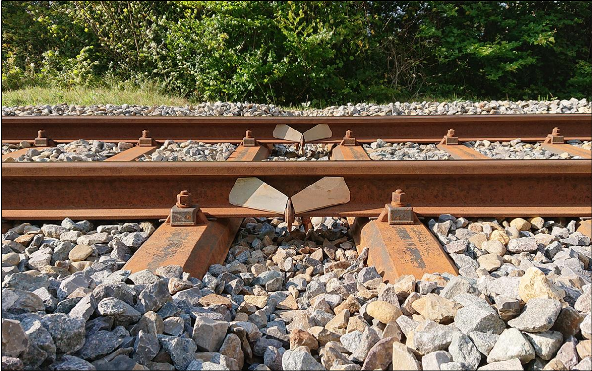
Abb. 12: Schottergraben und installierte Amphibienableitbleche. © WLS.CH, 2021
