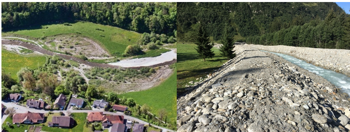
Abbildung 4: Gegensätzliche Entwicklungen – links nach Hochwasser 1999 neu entstandene Aue an der Bünz AG (Nr. 337), rechts neu geschüttete Hochwasserschutzdämme (unbefestigt) im Auengebiet Cholplatz GR (Nr. 411, Bild von 2019).
