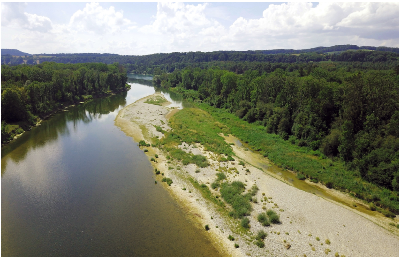
Bild 1: Die Baumaschinen sind abgezogen, die Thur kann die Gestaltung der Aue übernehmen: die revitalisierte Mündung der Thur in den Rhein (Foto: Robert Bänziger).
