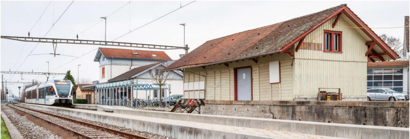
Die SBB bauen am Bahnhof Tägerwilen-Gottlieben eine Sendeanlage mit Funkmasten.
