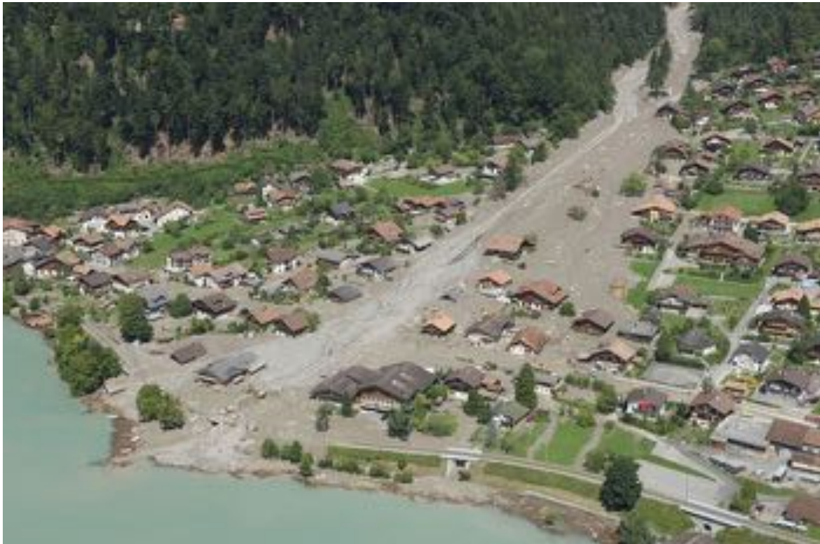
Abbildung 1-1: Ablagerungen von Schuttmassen nach dem Murgangereignis vom 23. August 2005 im Glyssibach (Brienz) (Foto: Schweizer Luftwaffe)
