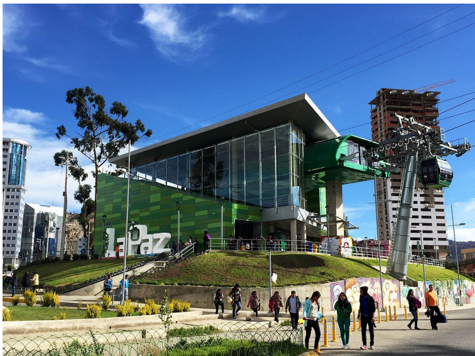
Abbildung: Dank dem weltweit grössten städtischen Seilbahnnetz verfügt La Paz/Bolivien über eine klimafreundliche Lösung mit Schweizer Technologie für den Nahverkehr. (Irapawi cable-car station in La Paz, Bolivia, 11. Januar 2017, EEJCC, CC BY-SA 4.0, https://commons.wikimedia.org/wiki/File:Estaci%C3%B3n_Irapawi.jpg )
