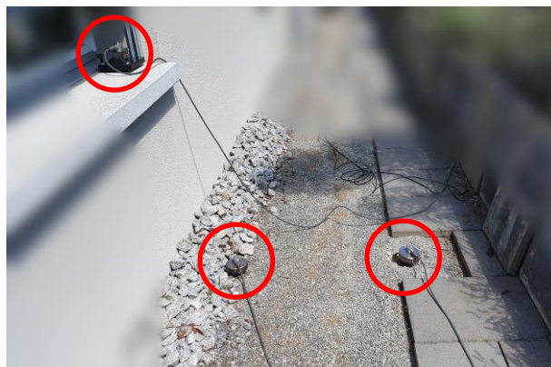
MP5 Fenstersims, MP3 hinter Injektionskörper, MP2 vor Injektionskörper
