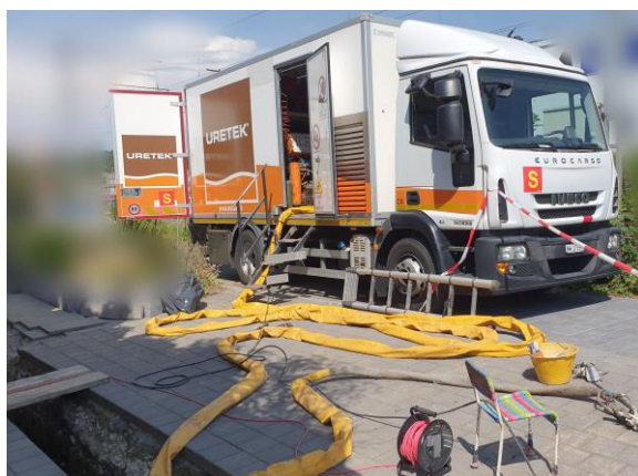
Baufahrzeug Uretek mit Injektionsausrüstung
