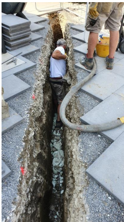
Injektionsarbeiten für 1. Bohrreihe
