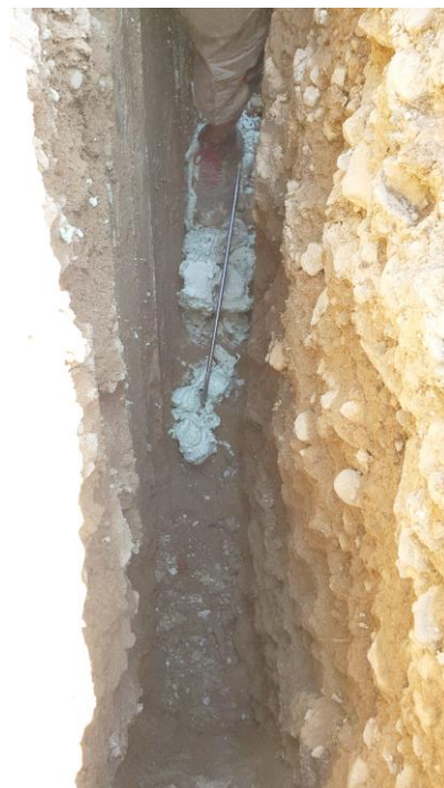
Boden nach 1. Injektion
