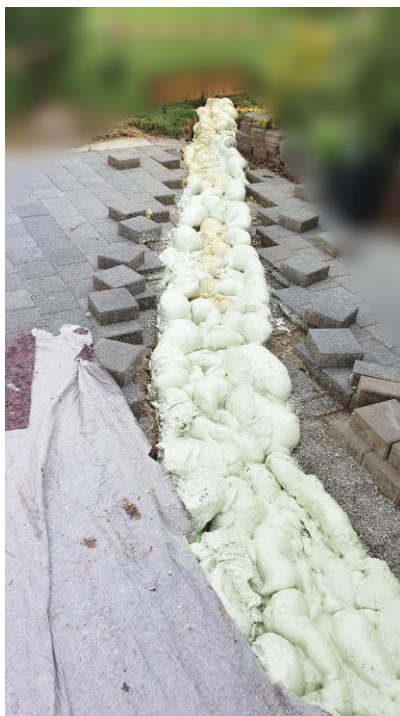
fertiger Injektionskörper (ohne Abschlussarbeiten)
