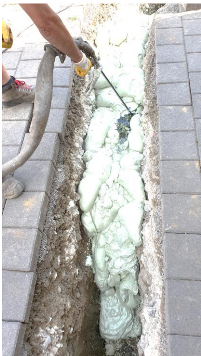
Ausschäumen des offenen Bodenschlitzes
