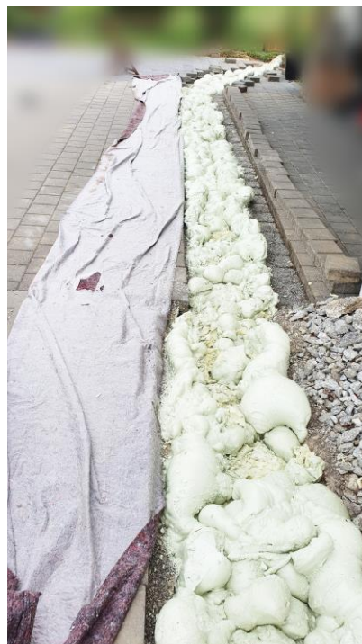
fertiger Injektionskörper (ohne Abschlussarbeiten)
