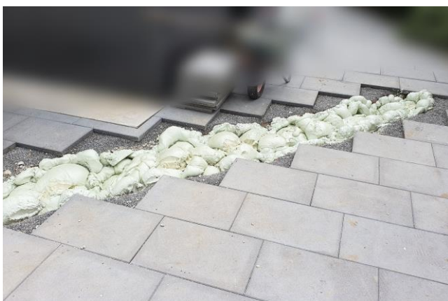
fertiger Injektionskörper (ohne Abschlussarbeiten)
