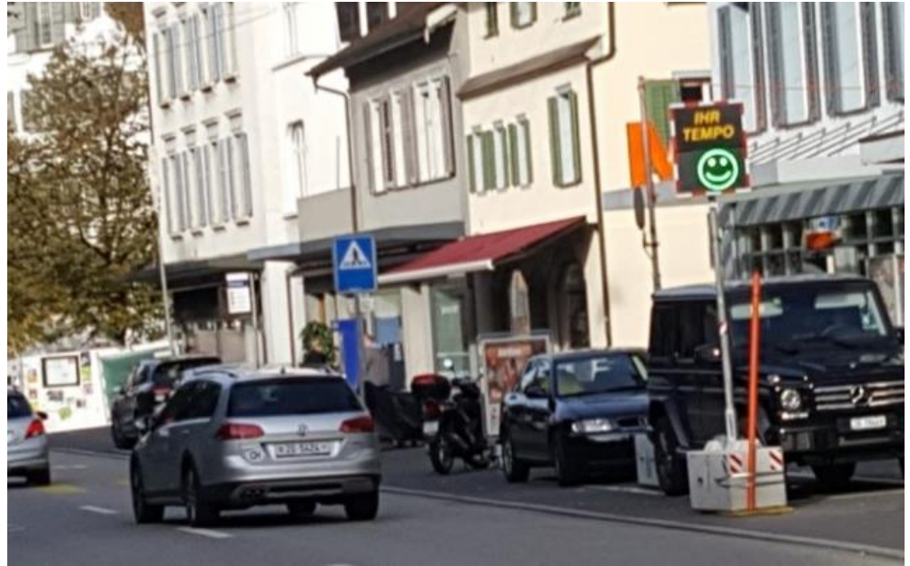
Wiederholung der Bodenmarkierung nach dem Fussgängerübergang und Speedy-Anzeige in Fahrrichtung Kolinplatz
