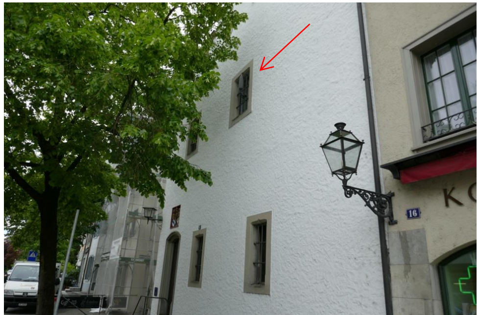
Abb. 1 Schallpegelmesser an Fenstergitter
