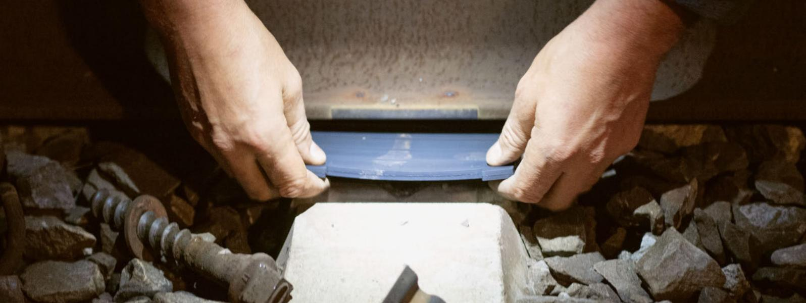
Die neue elastische Zwischenlage schont Betonschwelle und Schotter und reduziert den Schienenschallanteil.
