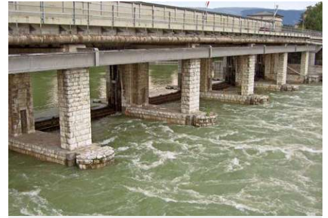
Der Abfluss der Aare im Nidau-Büren-Kanal und die Wasserpegel der drei Jurarandseen werden durch das Regulierwehr in Port (BE) gesteuert.
