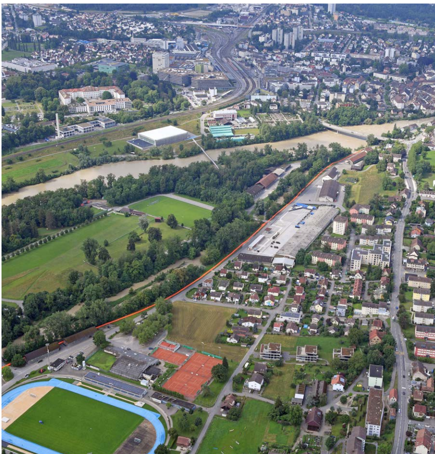
Um gefährdete Wohnquartiere im aargauischen Brugg vor der ausufernden Aare zu schützen, haben die Wehrdienste im Juli 2021 erfolgreich Beaver-Schläuche aufgestellt. Das orangefarbene Band verläuft vom linken unteren Rand diagonal zur Bildmitte.
