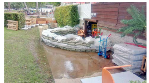
Kurzfristig organisierter Objektschutz mit Sandsäcken und Plastikfolien für das tief liegende Getränkelager eines ufernahen Restaurants in der Gemeinde Avenches (VD) am Murtensee.
