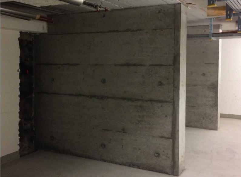
*Abb. C4: Einbau zweier neuer Stahlbetonwände in Gebäudelängsrichtung im Unter- und Erdgeschoss.*
