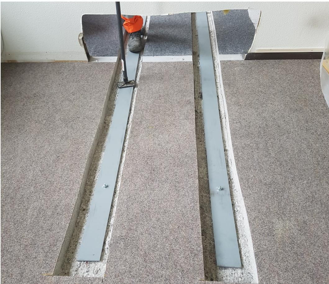
*Abb. C3: Kopplung der Dilatationsfugen mit Stahlblechen.*
