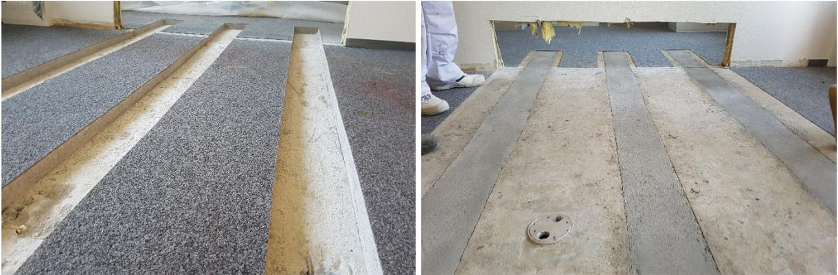
*Abb. C2: Schliessung der Dilatationsfugen (links vor und rechts nach dem Ausbetonieren).*
