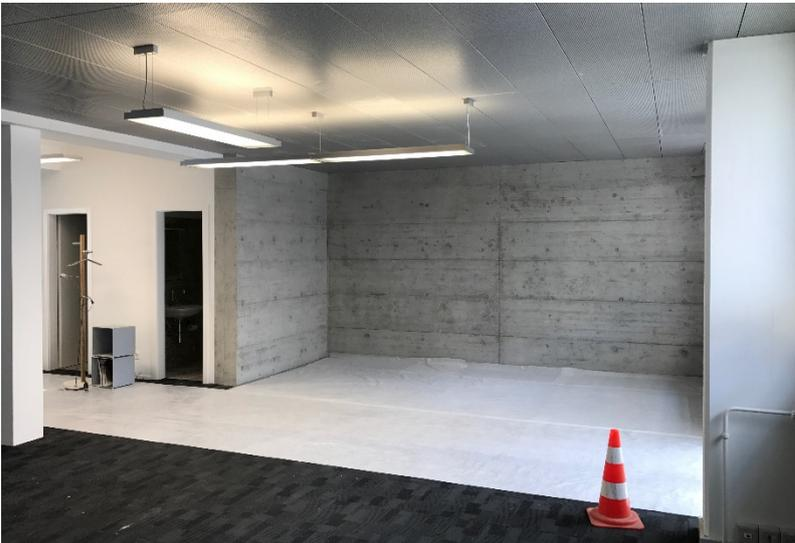
*Abb. C5: Einbau einer neuen Stahlbetonwand in Gebäudequerrichtung über alle Geschosse.*
