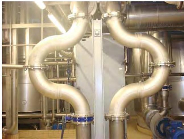
Abb. 9: Flexible Rohrleitungen mit U-förmigen Dehnungsbereichen (<http://www.z-montagen.ch>)
