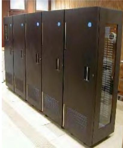
Abb. 3.19: Freistehender gegen Kippen ungesicherter Kontrollschrank (Uni Freiburg)
