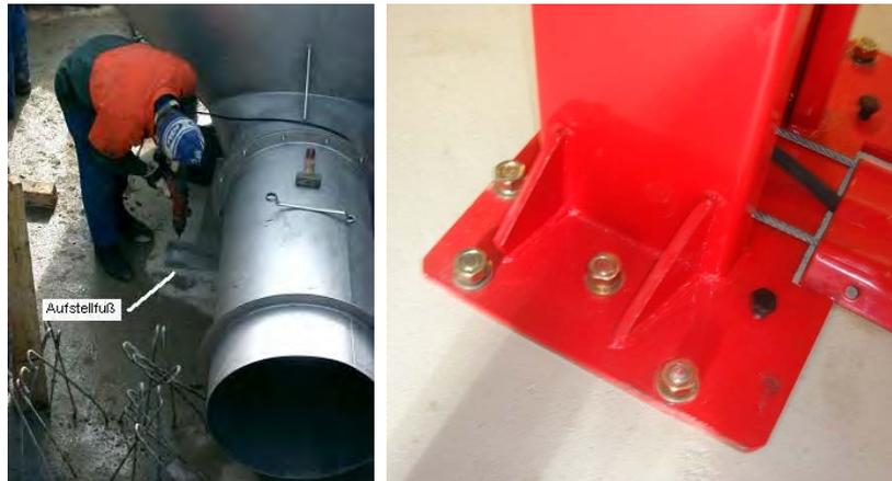
Abb. 5.15: Verankerung von Behältern und Gerätefüßen (HB-Technik, Profitexx)
