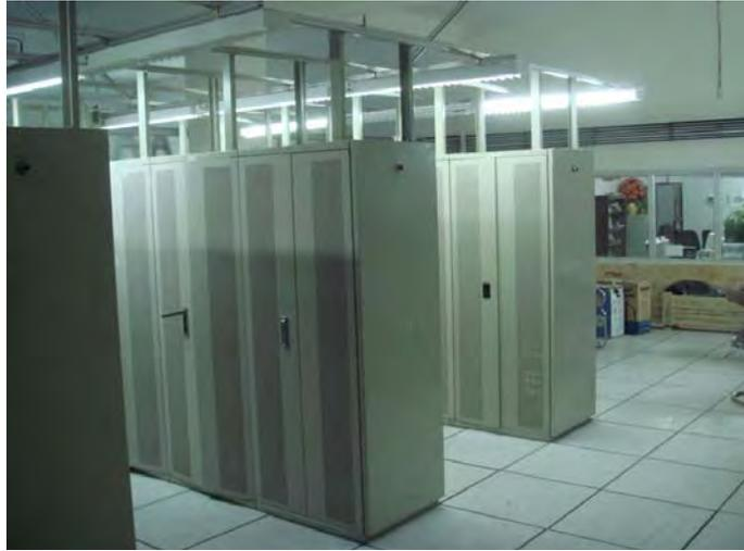
Abb. 5.9: Freistehende Schaltschränke mit Deckenverankerung (Foto Studer)
