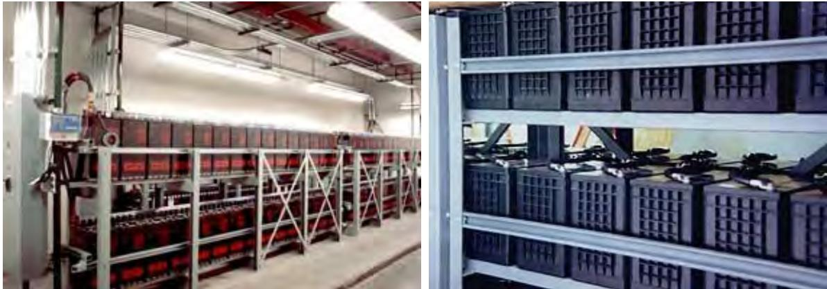
Abb. 19: Erdbebenerechte unabhängige Stromversorgung mit Sicherung der Batterien gegen Umkippen und Herausfallen (JMAEG, Phasor Corporation)
