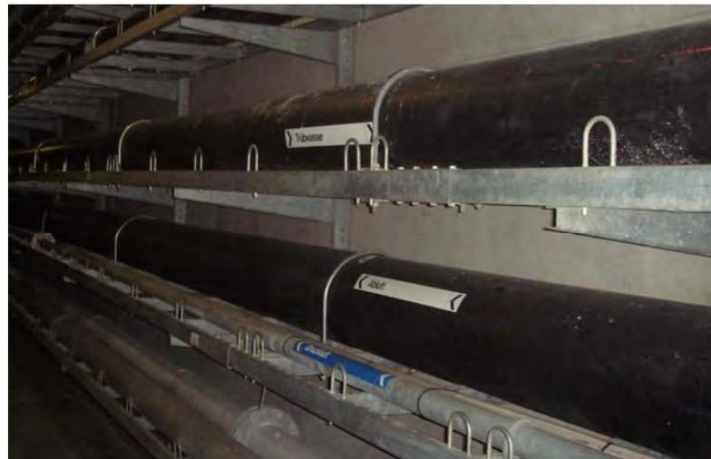
Abb. 3.17: Erdbebenegerechte Rohrleitungshalterungen in Querrichtung, zusätzliche Halterungen der Konsole in Längsrichtung sind jedoch erforderlich (siehe Abb. 5.7a), Gefährdung durch Abreissen und starke Deformationen in Längsrichtung (Foto Studer)
