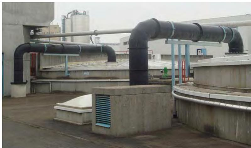
Abb. 3.15: Ungünstige auskragende unsymmetrische Rohrleitungshalterungen, Gefährdung durch Abreissen und starke Deformationen (Foto Studer)
