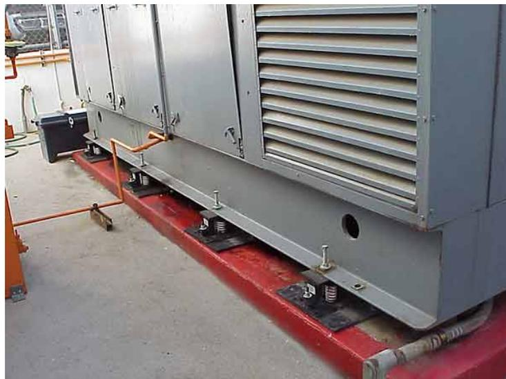
Abb. 20: Seismische Isolation eines Notstromgenerators. (<http://www.etccd.com>)
