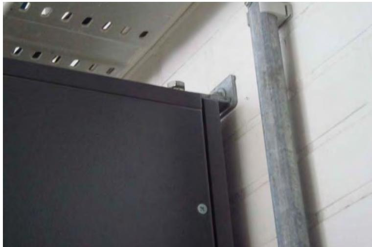
Abb. 5.10: Verankerung eines Schaltschranks an einer tragenden Wand (Foto Weber)
