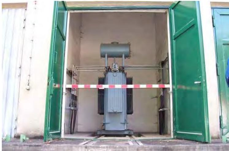
Abb. 3.20: Transformator auf Schienen gelagert, ohne ausreichende Kipp- und Rollsicherung (<http://www.obus-ew.de/>)
