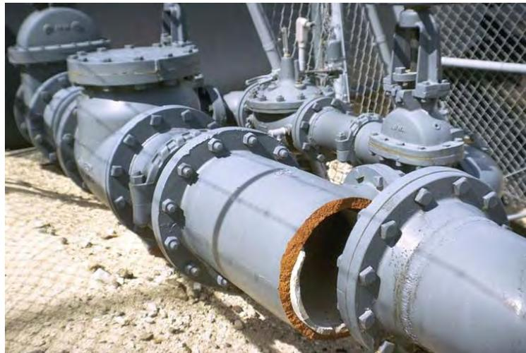
Abb. 3.1: Bruch spröder Wasserrohre einer Tankanlage beim San Fernando Erdbeben 1971 (NISEE 2010)
