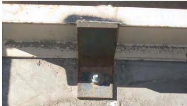
Abb. 11: Verankerung von Anlagenkomponenten gegen Kippen im Fundament, effektive Verankerung eines Kühlaggregates beim dem Sierra El Mayor Erdbeben 2010 in Mexicali (Hutchinson et al. 2010)
