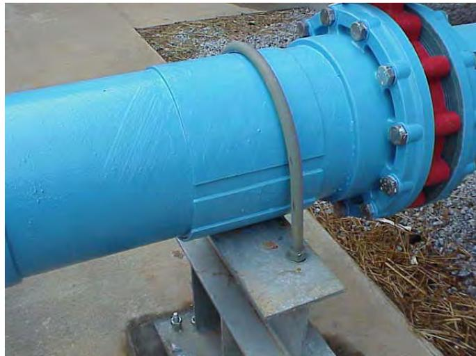
Abb. 5.8: Solide Rohrhalterung mittels U-Bolzen (ALA 2002)
