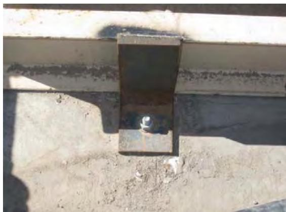
Abb. 5.17: Verankerung von Anlagenkomponenten gegen Kippen im Fundament, effektive Verankerung eines Kühlaggregates beim dem Sierra El Mayor Erdbeben 2010 in Mexicali (Hutchinson et al. 2010))
