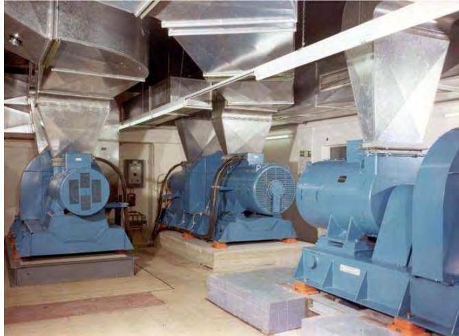
Abb. 5.20: Schwingungsisolation einer Lüftungsanlage mit Federelementen (<http://www.gerb.com>)
