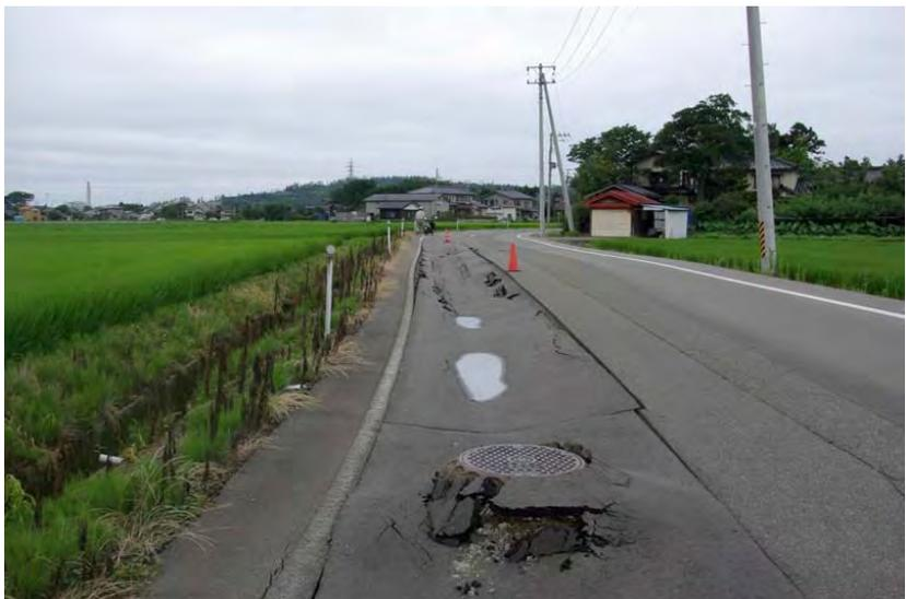
Abb. 3.6: Bodenverflüssigung im verfüllten Rohrgraben, Aufschwimmen des Schachtes und Sackungen durch Verdichtung des Füllmaterials (Kayen et al. 2007)
