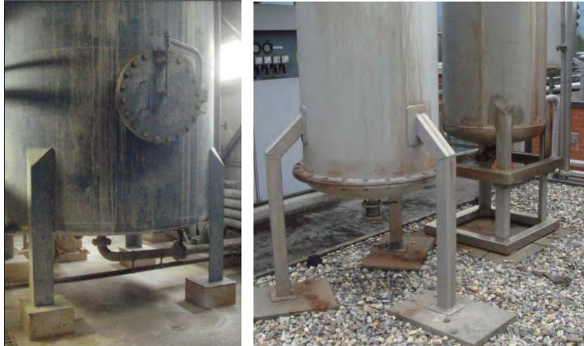
Abb. 3.16: Nicht ordnungsgemäss verankerte Behälteraufstellung, Gefährdung durch Umkippen und Verschieben (Foto Studer / Weber)
