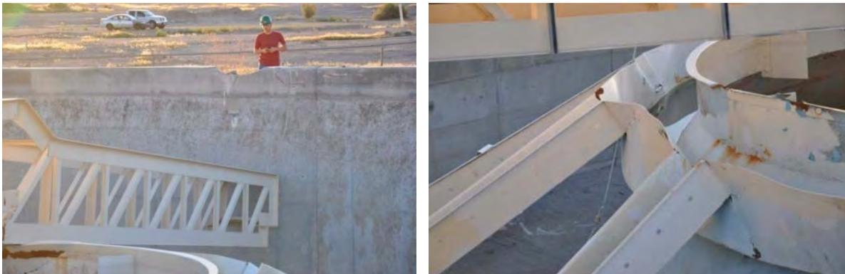
Abb. 3.8: Schädigungen eines Klärbeckens in Calexico Kalifornien beim Sierra El Mayor Erdbeben 2010 (Hutchison et al. 2010)
