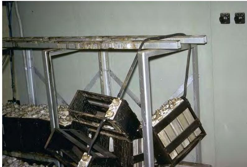
Abb. 3.13: Versagen der unabhängigen Stromversorgung durch umfallen der Batteriehalterung beim San Fernando Erdbeben 1971 (Foto Steinbrugge)
