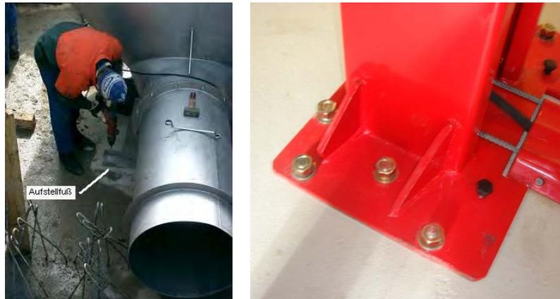
Abb. 10: Verankerung von Behältern und Gerätefüßen (HB-Technik, Profitexx)
