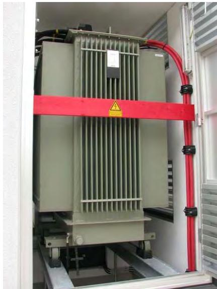
Abb. 5.16: Transformator auf Schienen gelagert mit Kipp- und Rollssicherung
