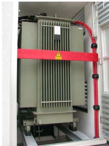
Abb. 18: Transformator auf Schienen gelagert mit Kipp- und Rollsicherung
