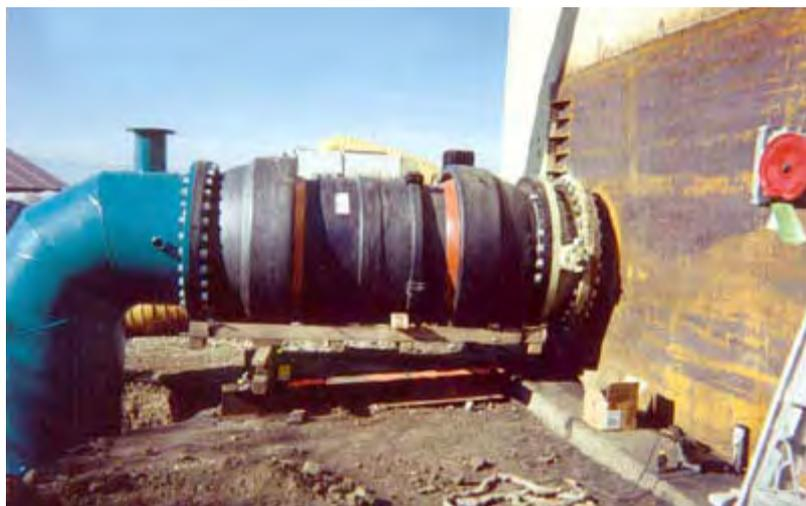
Abb. 5.6: Flexibler Rohranschluss an ein Tankbauwerk (<http://www.sccitanks.com>)
