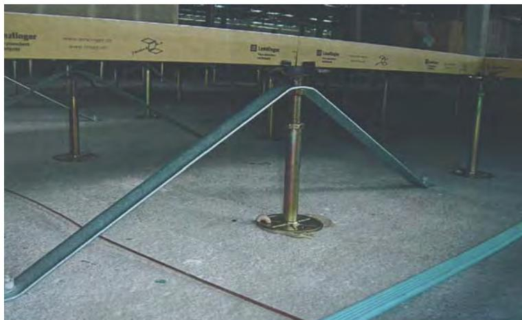
Abb. 5.11: Sicherung gegen Abheben und Kippen von aufgeständerten Fussböden am Boden
