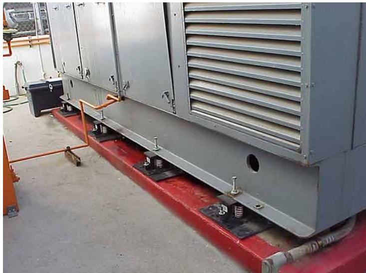
Abb. 5.21: Seismische Isolation eines Notstromgenerators. (<http://www.etccd.com>)
