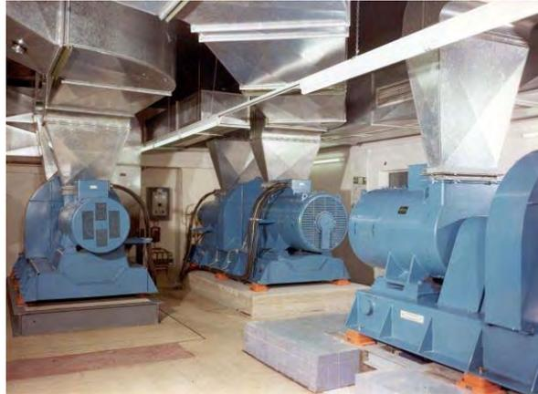
Abb. 13: Schwingungsisolation einer Lüftungsanlage mit Federelementen (<http://www.gerb.com>)
