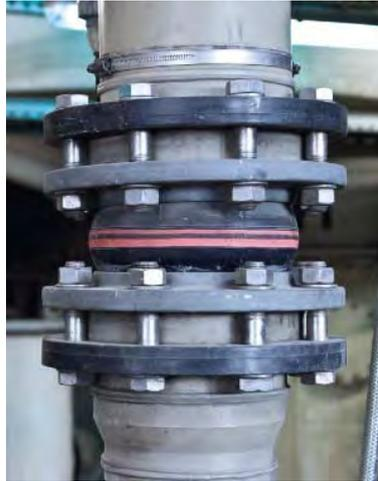
Abb. 8: Flexible Rohrmuffe aus Gummi (<http://www.ditec-kt.de>)
