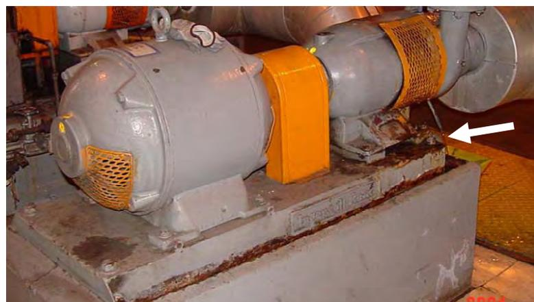
Abb. 3.18: Korrodierte oder schlechte Befestigung bzw. Verankerung von Pumpenanlagen (ALA 2004)
