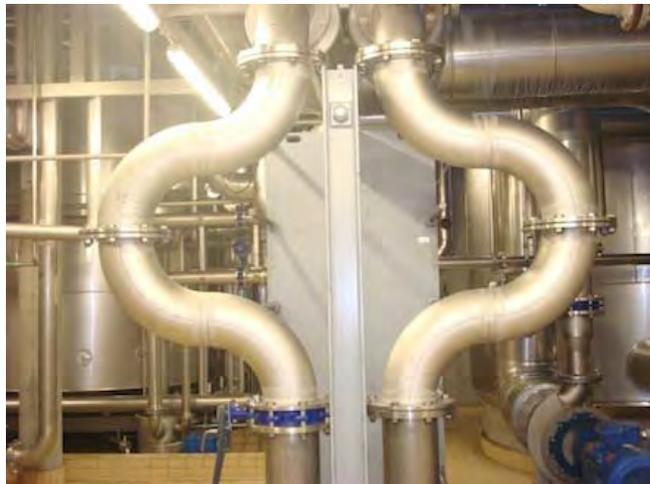
Abb. 5.5: flexible Rohrleitungen mit U-förmigen Dehnungsbereichen (<http://www.z-montagen.ch>)
