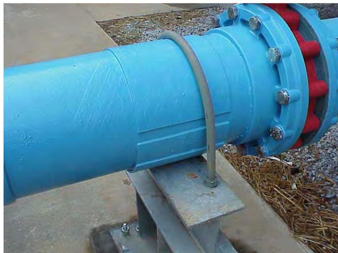
Abb. 2: Solide Rohrhalterung mittels U-Bolzen (ALA 2002)
