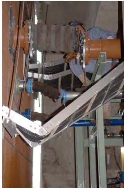
Abb. 3.7: Rohrleitungsabriss gelenkiger Verbindungen durch sehr grosse Deformationen bei der Kashiwazaki Kläranlage beim Niigata Chuetsu Oki Erdbeben 2007 (Kayen et al. 2007)
