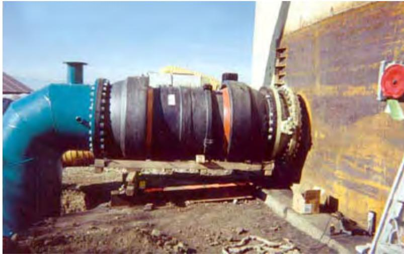
Abb. 6: Flexibler Rohranschluss an ein Tankbauwerk (<http://www.sccitanks.com>)
