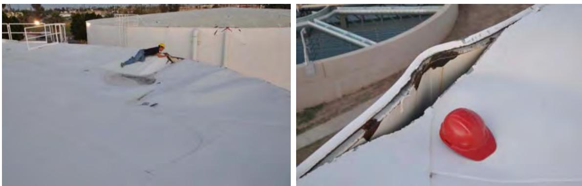
Abb. 3.12: Tankschäden der Kläranlage in Calexico Mexico beim Sierra El Mayor Erdbeben 2010 (Hutchinson et al. 2010)
