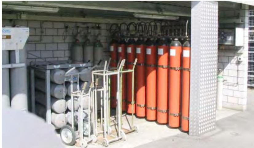
Abb. 5.13: Gegen Umfallen gesicherte Gasflaschen (Foto Studer)
