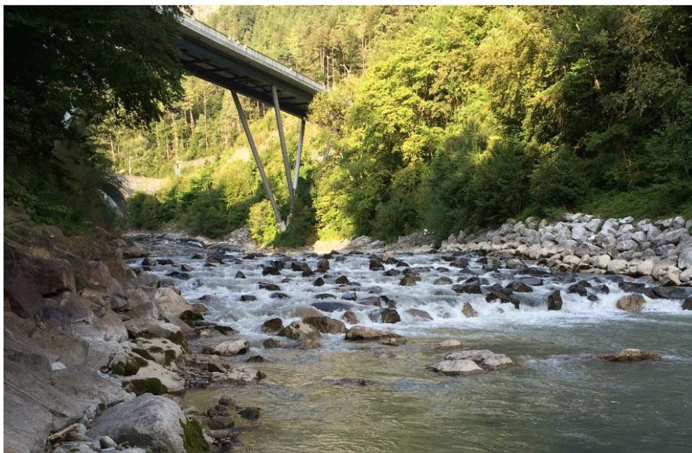
Abb. 8 Beispiel einer aufgelösten Blockrampe.
