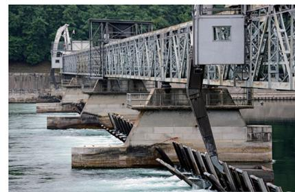
Regulierwehr Miorina bei Sesto Calende (I). Das Wehr besteht aus 120 Metallschützen, die vollständig abgelegt werden können. Bedient werden sie durch Hebelarme, die auf Laufkränen angebracht sind.
