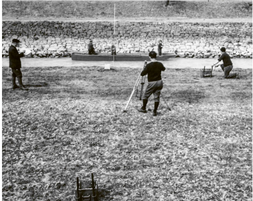
Seit 1868 werden in der Schweiz Fließgewässer vermessen – zu Beginn mit Messdraht und Messlatte, wie hier im Jahr 1969.
