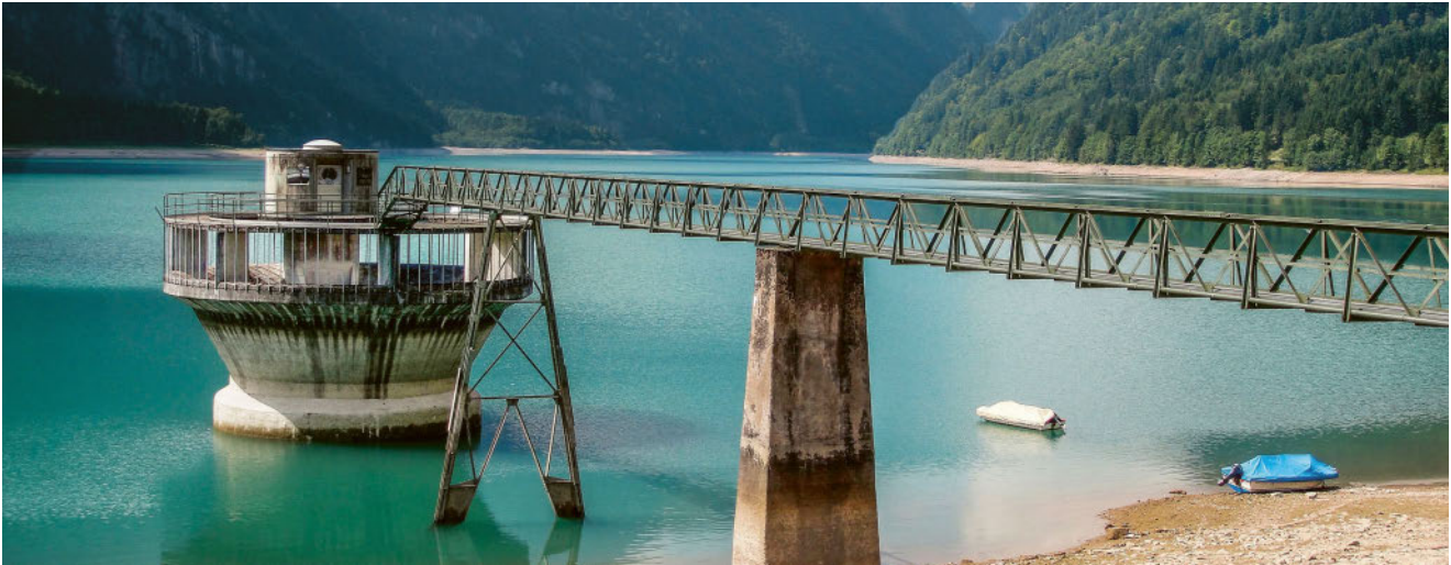
Bei Hochwasser dient der Betontrichter im Klöntalersee als Überlauf.
