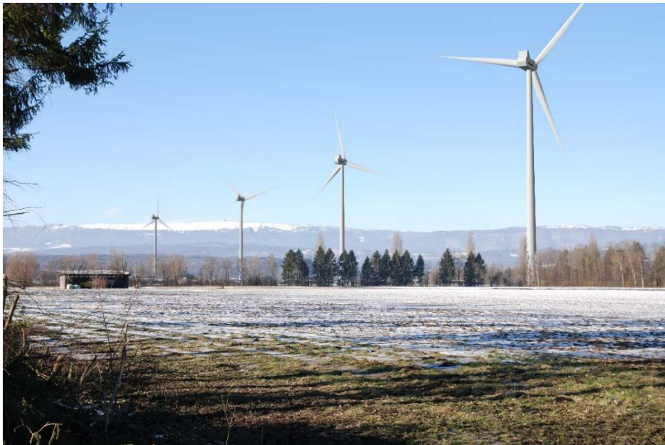
Abbildung 15: Beispiel Berücksichtigung der Uhrzeit bzw. korrekte Richtung des Schattenwurfs (oben: falsche Uhrzeit, unten: korrekte Uhrzeit).
