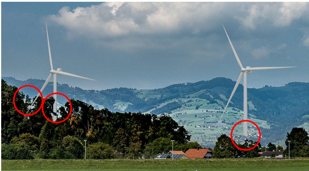
Abbildung 14: Beispiel Berücksichtigung von Sichthindernissen: unsorgfältige Bearbeitung der Sichthindernisse. Bei der linken Anlage sollte das unterste Rotorblatt hinter dem Wald verschwinden; bei der rechten Anlage wurde zu viel vom Mast abgeschnitten.
