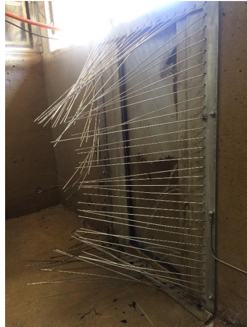
Abbildung 23: Stabkehle am Einstieg des ZB Hagneck
