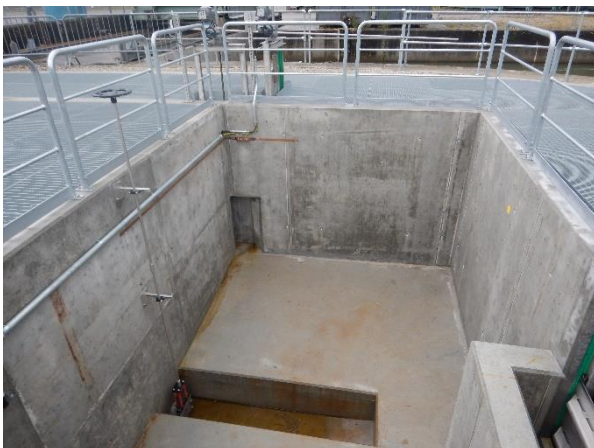
Abbildung 21: Zählbecken Beznau mit Einstieg (hinten links), Fangrinne (vorne links) und Einlauf (vorne rechts)
