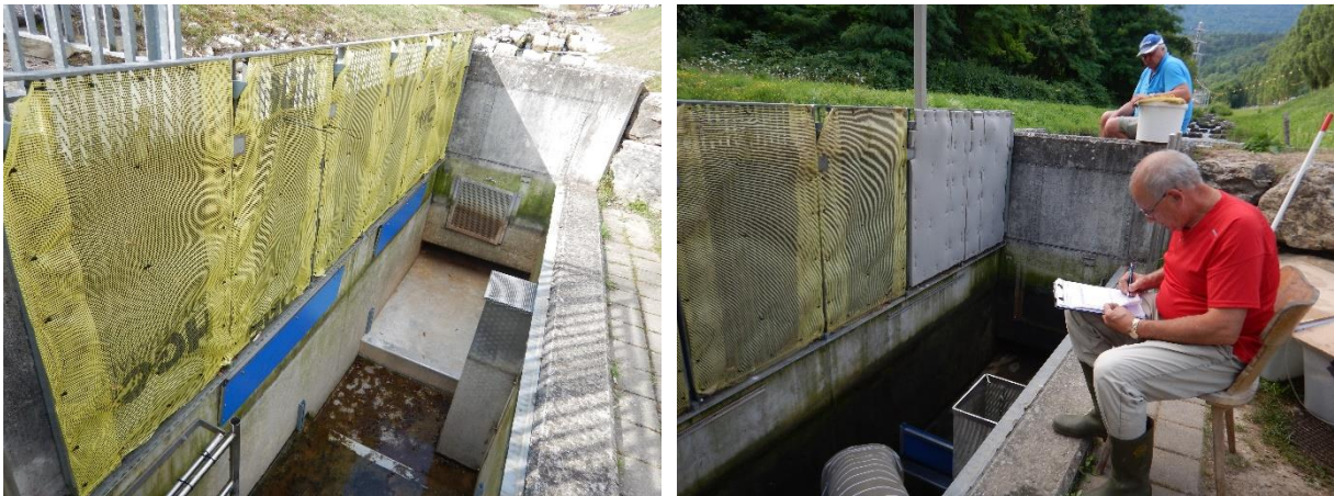
Abbildung 9: Massnahmen gegen Fischverletzungen: Ein feinmaschiges Netz (links, gelb) gegen das Auspringen von Fischen, Schaumstoffmatten (rechts, grau) gegen Kopfverletzungen. Die blauen Bretter im linken Bild können in Schienen neben der Fangrinne eingesetzt werden, damit die Fische nicht mehr aus dieser entweichen können (vgl. rechtes Bild).
