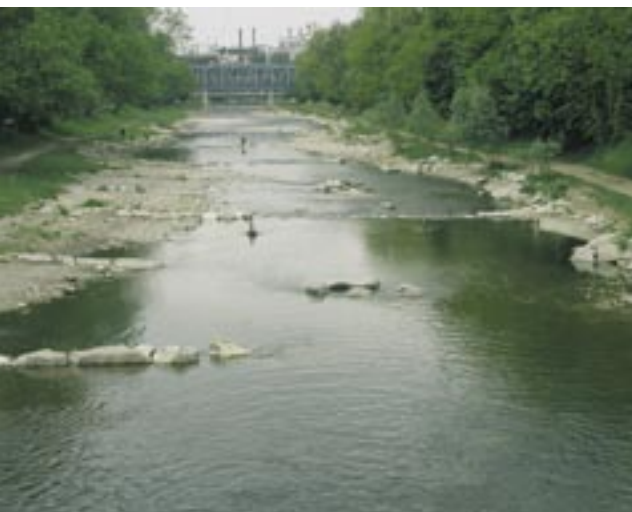
Uferaufweitungen – wie hier an der Wiese in Basel – können die Trinkwasserqualität in flussnahen Förderbrunnen beeinträchtigen.
