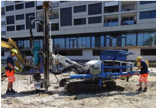
Forages pour les lances d’injection
