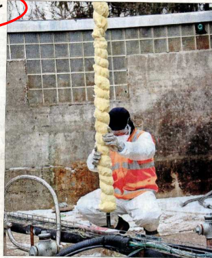
Am Dienstag sind die Heizkabeln in den Boden eingelassen worden. Foto: Torsten Ströbele
