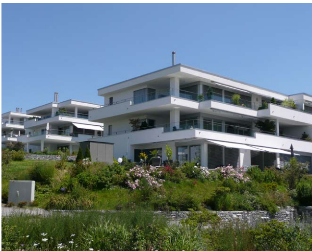
Traitement des eaux pluviales à Ostermundigen Photo: Michael Burkhardt
