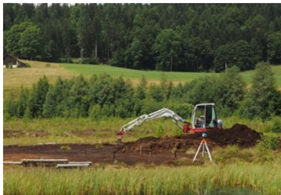
Travaux de terrassement en 2018
