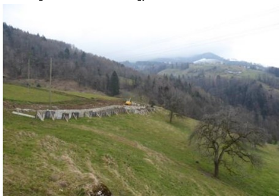
Pendant la réfection
