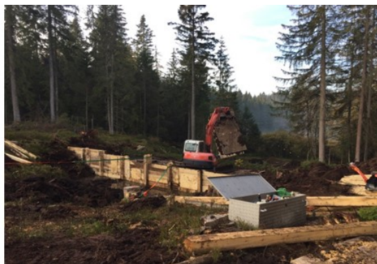
Travaux d'assainissement (octobre 2018)
