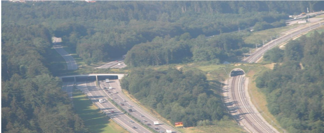
Fig. 9 Vue aérienne des passages à faune du Birchiwald sur l'A1 (à gauche) et sur le nouveau tronçon ferroviaire (à droite), près de Kirchberg (BE).
