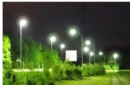
Double éclairage inutile au carrefour autoroutier de Lyss Nord (source : TTE de Berne)
