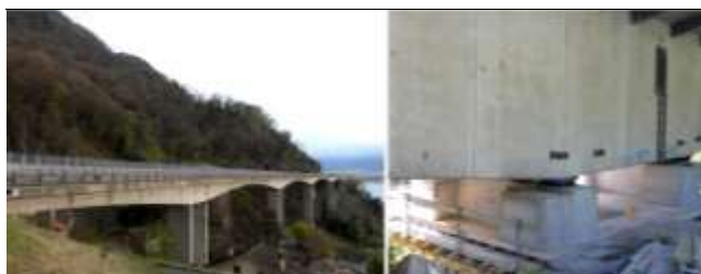
Mesures parasismiques, viaduc de Chillon (image T. Wenk)
