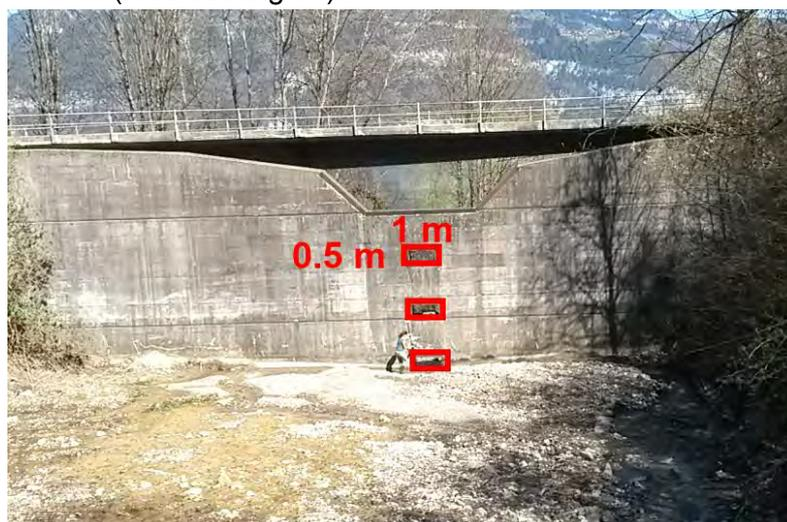
Abbildung 16: Bezeichnung des kleinsten Masses des Durchlasses. Geschiebesammler am Fritzenbach in Leissigen. Durchlass: Breite = 1 m, Höhe = 0.5 m. (Aufnahmedatum: 24. April 2015).
