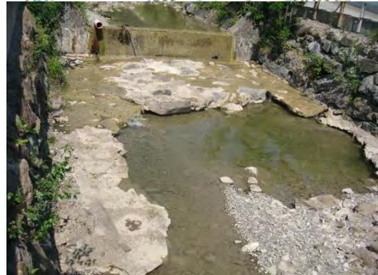
6 Erosierte Deckschicht unterhalb Sperre
