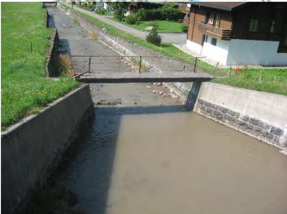
2 Sperrentreppen mit befestigter Böschung
