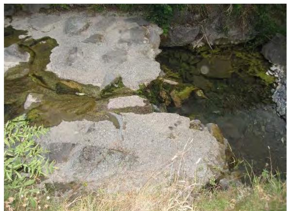
5 Beschädigter Überfall bei Blockschwelle 12
