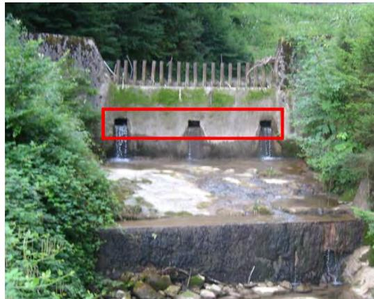
Abbildung 18: Bezeichnung der horizontalen Orientierung der Öffnung. Geschiebesammler am Kummetbach in Attinghausen. Rote Markierung = horizontale Orientierung des Durchlasses.
