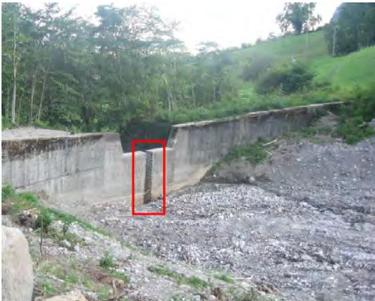
Abbildung 17: Bezeichnung der vertikalen Orientierung der Öffnung. Schlitzsperre am Melbach in Kerns. Rote Markierung = vertikale Orientierung des Durchlasses.
