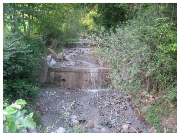
5 Betonsperrre mit gering ausgeprägtem Kolken
