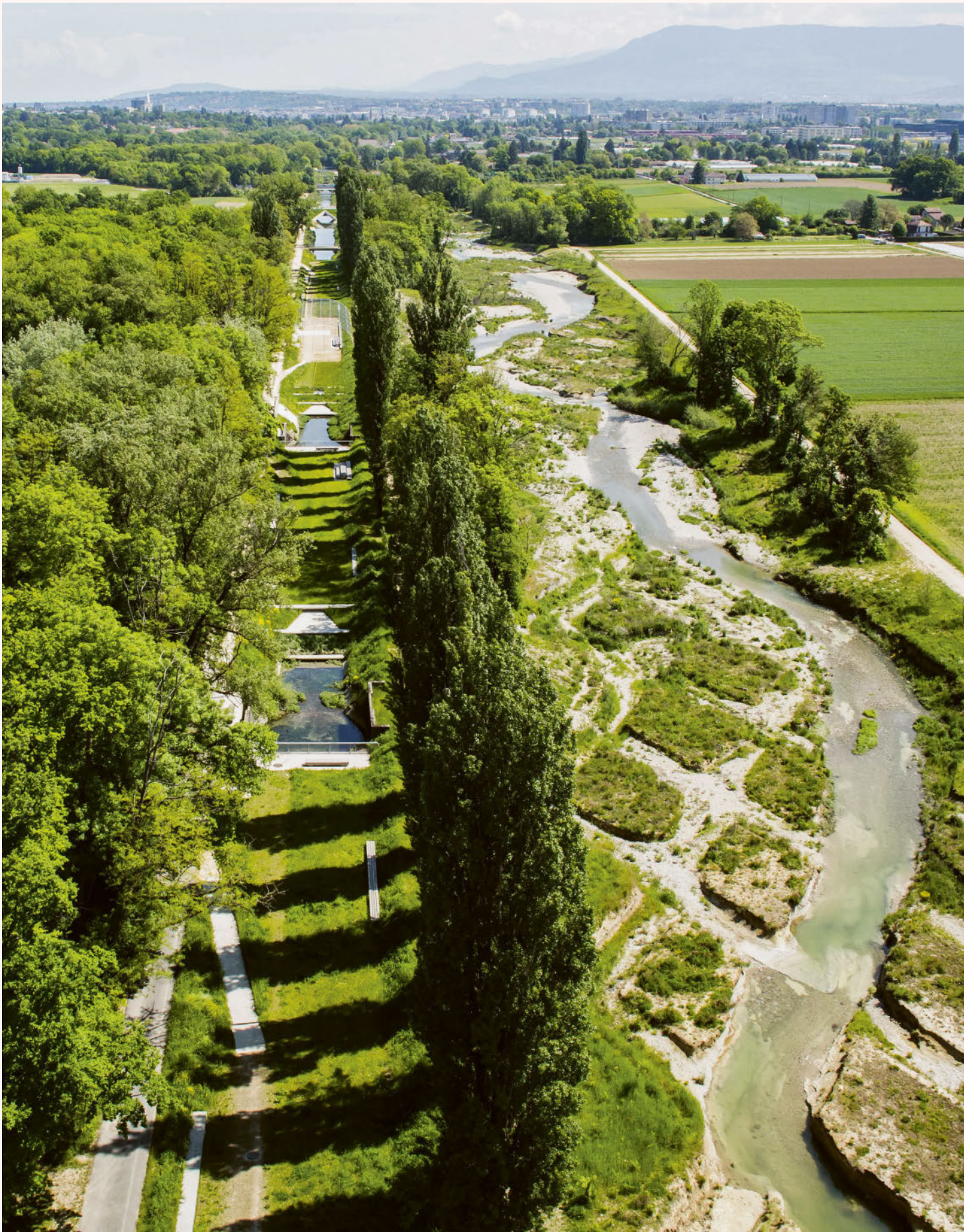
Depuis qu'elle a été revitalisée, dans le canton de Genève, l'Aire peut se frayer son propre chemin au travers de sillons en forme de losanges.
