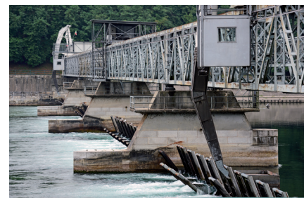
Barrage de régulation de la Miorina, près de Sesto Calende (I). Le barrage est équipé de 120 clapets métalliques, qui peuvent être abaissés complètement et sont manœuvrés par les flèches de grues mobiles.
