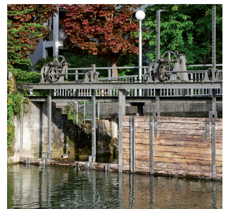
Le premier barrage à l'exutoire du lac de Zoug a été érigé en 1592 en vue de réguler le débit de la Lorze. Malheureusement, il n'en existe plus aucune image. Le barrage actuel a été construit en 1943 et assaini en 2002. Il est équipé de quatre vannes levantes, c'est-à-dire quatre panneaux en bois d'une largeur de 4 m chacun. Trois de ces vannes disposent d'un moteur électrique, la quatrième est activée manuellement au moyen de l'ancienne roue à manivelle.
