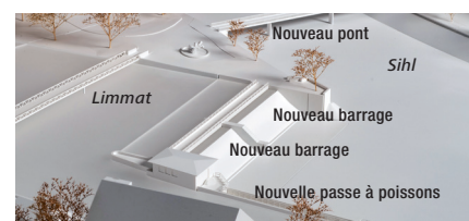
La pièce maîtresse du système de régulation du lac de Zurich est le barrage du Platzspitz, édifié en 1951 (en haut), dont l'assainissement devrait se faire dans les années à venir (modèle, en bas).
