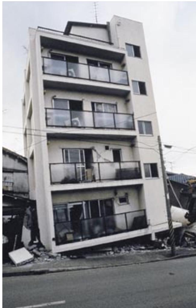
**Société industrielle vulnérable: les destructions à Kobe montrent le prix qu'il faut payer à cause des points faibles des constructions, tels que fondations insuffisantes, étages ou rez-de-chaussée trop fragiles.**
