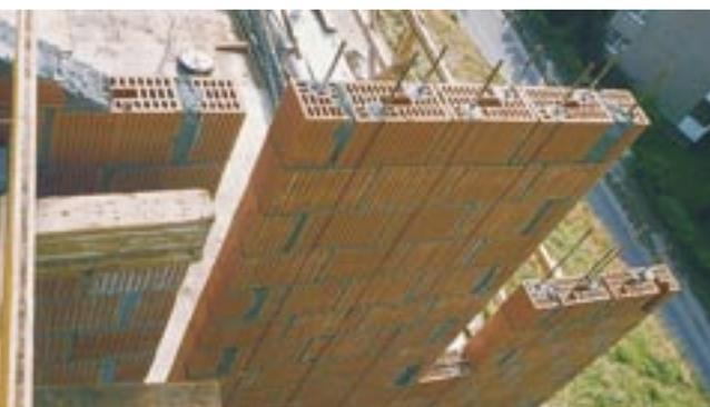
**Mesures constructives pour une meilleure protection parasismique: renforcement des systèmes de refends, lamelles en acier pour consolider un mur de maçonnerie, armatures transversales dans le béton armé et mur de briques armé.**
