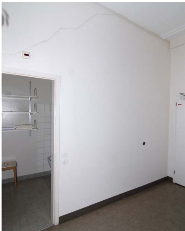
Fig. A3.3: Points faibles potentiels typiques dans le Markgräflerhof : cloisons intérieures minces (à gauche) et planchers en bois flexibles (à droite), photos : Wenk 2012
