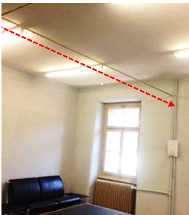
Fig. A2.4 Barres en traction au deuxième étage
