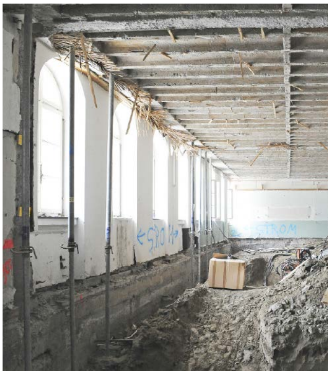
Fig. A1.8 : Excavation pour les parois parasismiques dans la zone des salles de classe (à gauche) et salle de classe avec nouvelle paroi parasismique (à droite), photos : 2012-2014
