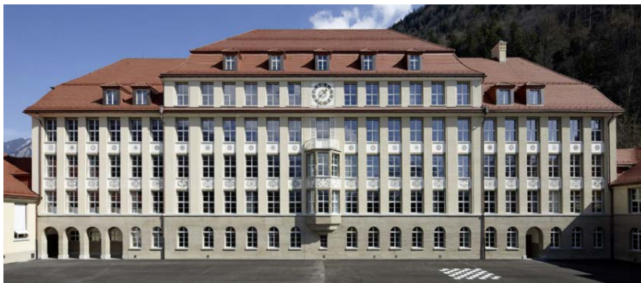
Fig. A1.1 : Bâtiment du lycée Quader à Coire, façade ouest. Propriétaire : ville de Coire (GR), photo : 2014
