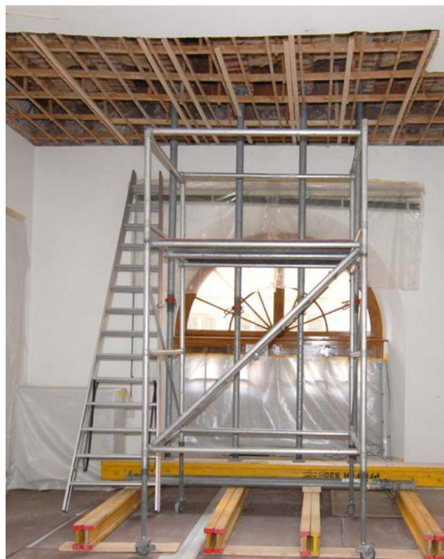
Fig. A3.3: Points faibles potentiels typiques dans le Markgräflerhof : cloisons intérieures minces (à gauche) et planchers en bois flexibles (à droite), photos : Wenk 2012
