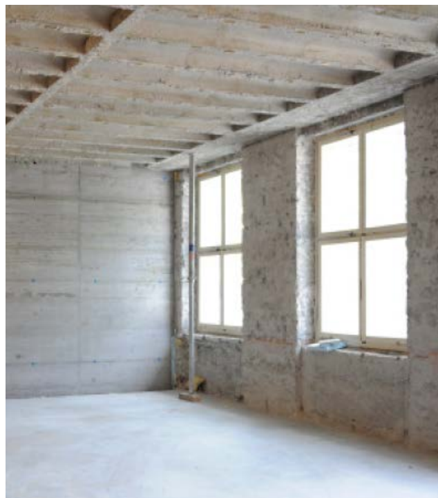
Fig. A1.8 : Excavation pour les parois parasismiques dans la zone des salles de classe (à gauche) et salle de classe avec nouvelle paroi parasismique (à droite), photos : 2012-2014
