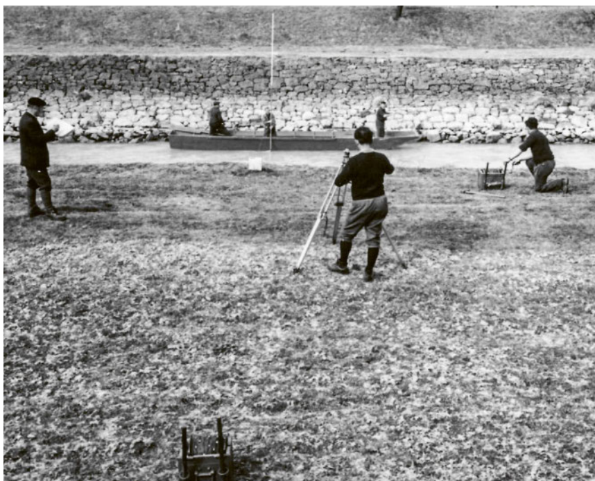
La mensuration des cours d'eau a débuté en Suisse en 1868 – au début, au moyen de fils de mesure et de mires graduées, comme ici en 1969.
