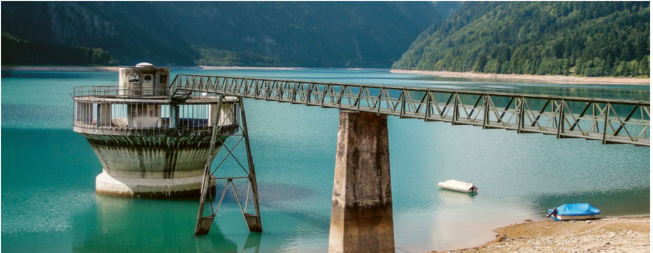
En cas de crue, l'entonnoir en béton sert de déversoir au lac du Klöntal (GL).
