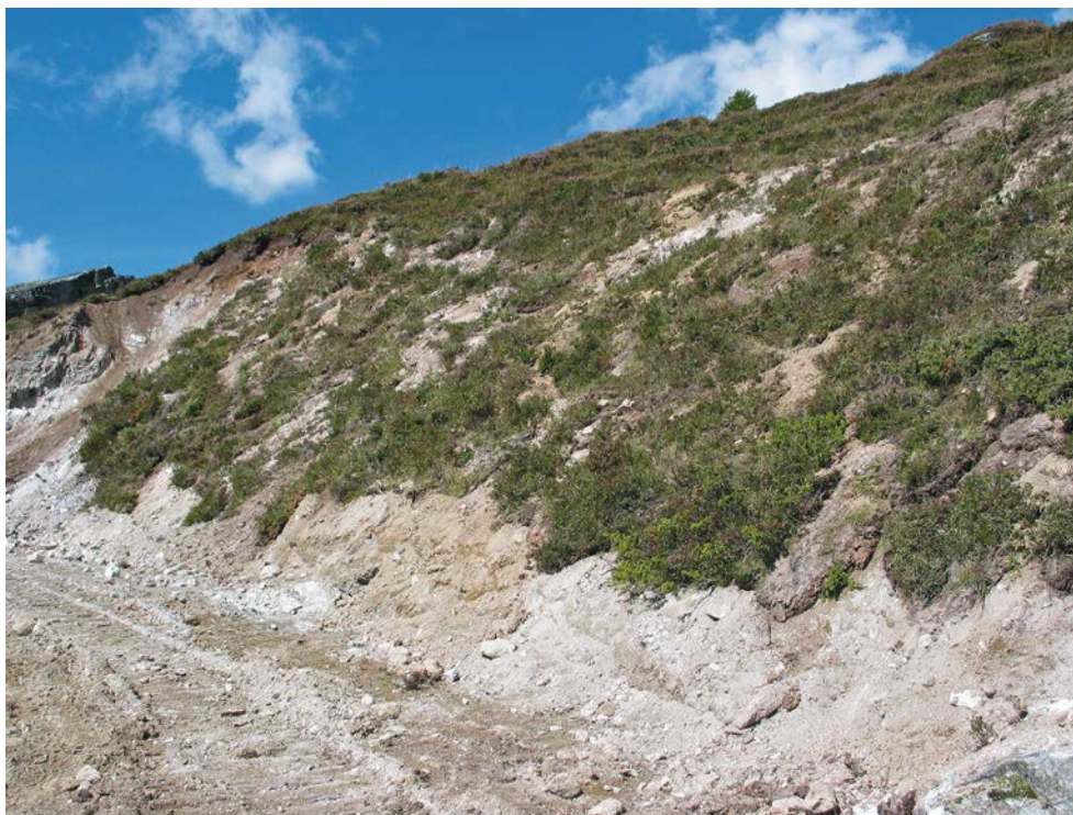
Fig. 57 > Grâce au SER, le talus au bord de la piste de chantier a été aménagé de manière à s'intégrer au mieux dans le paysage et à permettre l'utilisation sur place de la plus grande partie des matériaux.
