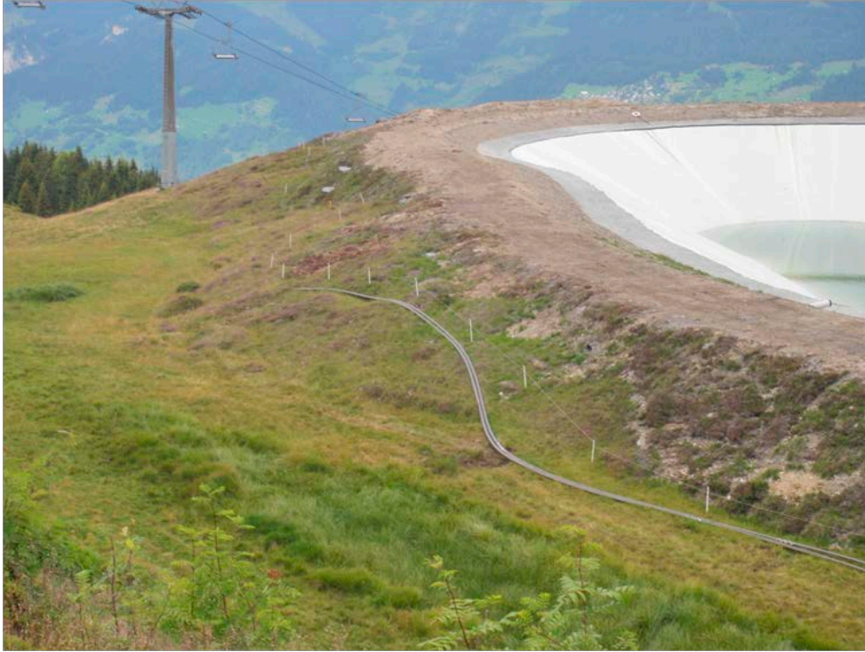
Fig. 10 > Reconstitution soignée après la construction d'un bassin artificiel.
