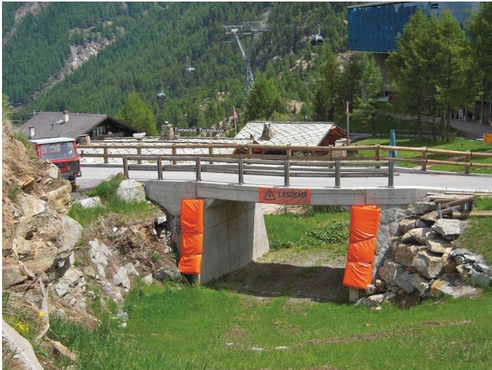
Fig. 6 > De nombreux ouvrages sont réalisés pour permettre le franchissement de voies de circulation. Le recours à des matériaux naturels (pierre) et le retrait des protections en période estivale permet de réduire leur impact sur le paysage.
