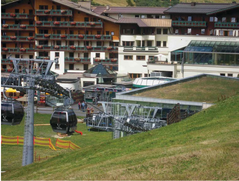
Fig. 56 > L'implantation judicieuse et la végétalisation de la toiture ont permis de limiter l'impact sur le paysage de cette station de départ.
