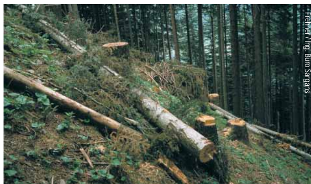
Ill. 7: Sapins blancs au sol à Pfäfers. Une coupe de bois normale a eu lieu dans un premier temps (surtout des épicéas): les arbres ont été abattus, puis évacués par câble-grue. Dans une seconde phase, les sapins blancs marqués au préalable ont été abattus puis déposés obliquement par rapport à la ligne de pente. Ces troncs servent à freiner les pierres.
