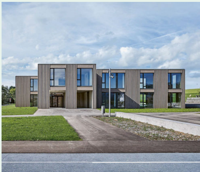
Le bois de l'école de Vaulruz (FR) provient de la forêt communale toute proche.
