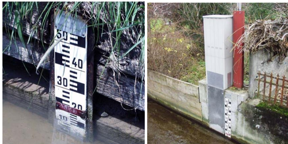
Figure 13 : Divers procédés existent pour contrôler le respect des débits de dotation : échelles limnimétriques, échancrures marquant le débit de dotation, Telelog.
