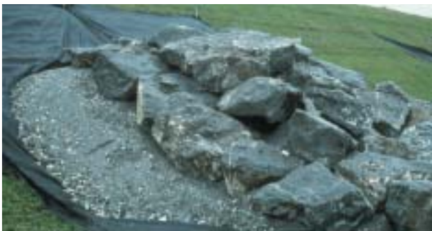
Le renforcement des digues représentant un danger sur le Rhône, une mesure d'urgence importante prise en octobre 2000.
