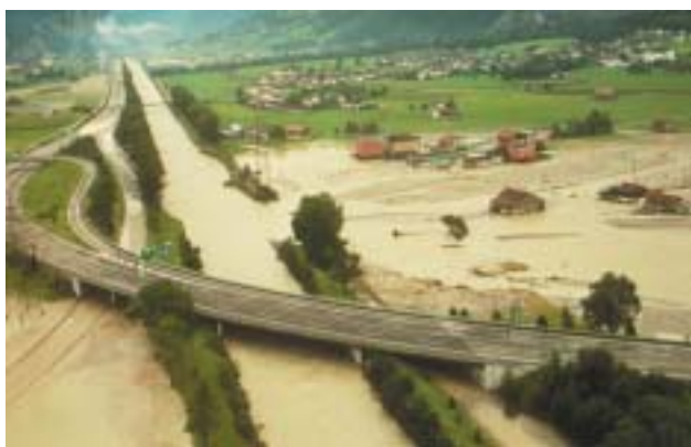
Uri 1987: Plus de 700 bâtiments ont été inondés, suite à des ruptures de digues dans la plaine de la Reuss.
