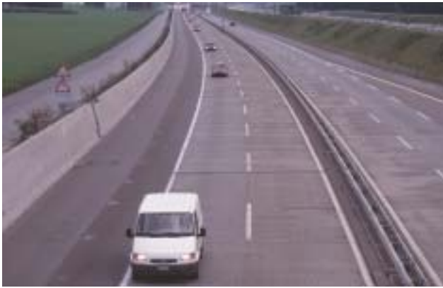
Mesures de protection contre les crues dans le canton d'Uri: Si la Reuss a un débit trop élevé, l'autoroute joue le rôle de lit majeur. Cette mesure permet d'éviter des dégâts dans la zone d'habitation tels que ceux engendrés en 1987.
