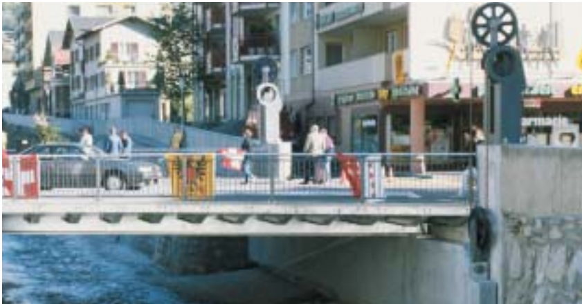
Gestion du risque à Brigue: ce pont levant automatique atténue le danger lié aux crues de la Saltina.
