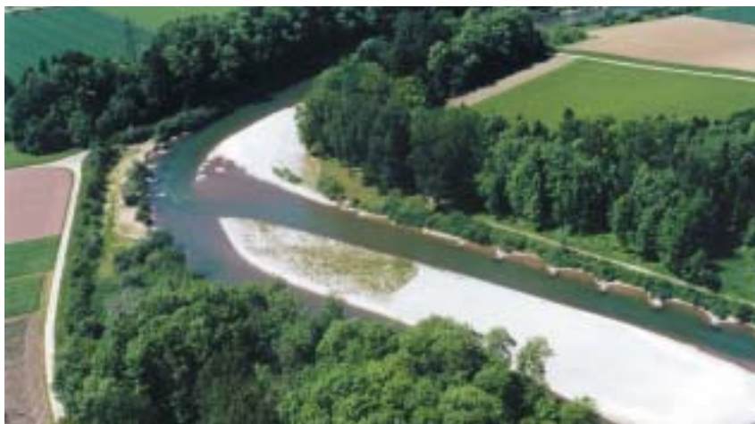
Le tracé de la Thur élargi près de Gütighausen ZH: Une protection contre les crues moderne comprend également la création d'espaces de rétention des crues naturels, où un cours d'eau en crue a la possibilité de quitter son lit sans trop de dégâts.
