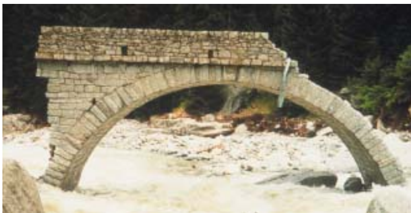
Uri 1987: La violence de la crue a détruit les liaisons routières et ferroviaires.
