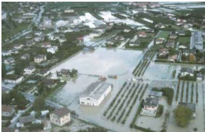
Les suites d'une rupture de digue du Rhône près de Chamoson VS en octobre 2000. Les déficits de protection dans la plaine du Rhône sont trop importants.
