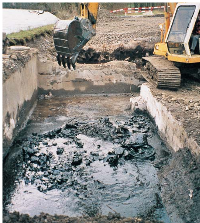
Elimination de résidus contaminés sur le site d'une ancienne usine à gaz dans le quartier bernois de Marzili: les informations géologiques sur la constitution du sous-sol et la distribution des eaux souterraines sont utiles à l'estimation du risque et à l'assainissement bien ciblé d'anciennes décharges.
