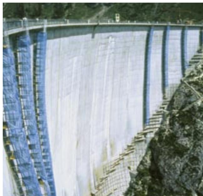
La sécurité structurale de l'ouvrage de retenue est assurée: travaux d'entretien du bassin d'Airolo TI (à gauche) et assainissement du barrage en béton de Zeuzier VS (à droite) après sa fissuration suite à la construction d'une galerie de sondage.
