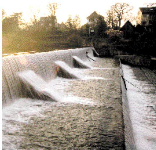
Fig. 7e: Seuils bétonés à l'intérieur d'un ouvrage de retenue à quatre niveaux
