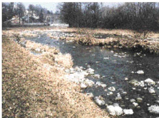
**Fig. 2b:** Cours d'eau renaturé à profil déterminé et à cours présentant une variabilité prononcée de la largeur du lit mouillé
