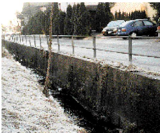
Fig. 6h: Rives absentes: la surface carrossable, protégée par un mur, s'étend jusqu'au bord de l'eau.
