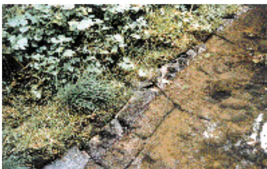
**Fig. 4f:** Cours d'eau avec un renforcement imperméable du pied de la berge: que les interstices soient jointoyés ou non avec du mortier, ce type de renforcement est classé dans la catégorie «pierres naturelles, étanche».
