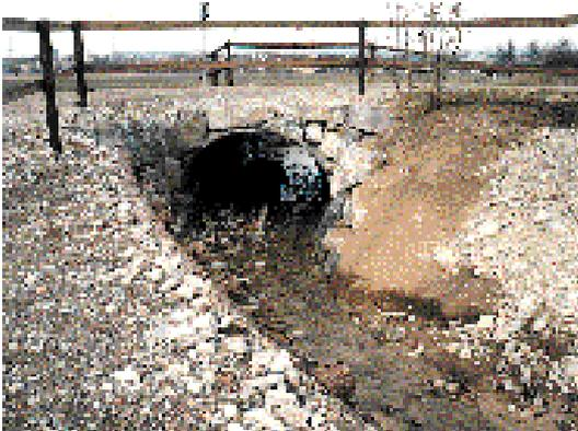
Fig. 10e: Passage en tuyau Armco
