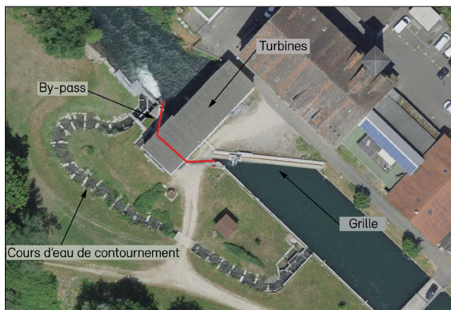
Fig. 78 : Aperçu de la centrale de Stroppe, sur la Limmat, avec l'ouvrage de dévalaison
