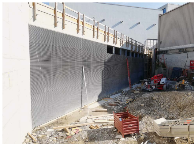
Fig. 46 : Grille horizontale en construction Centrale de Dietikon sur la Limmat (canton de Zurich).
