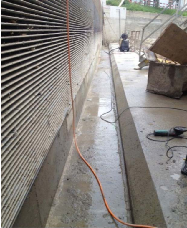
Fig. 79 : Grille horizontale avec gouttière collectrice
