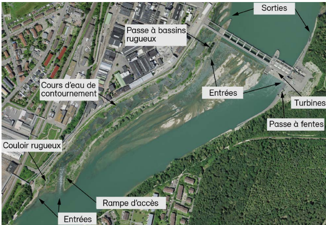
Fig. 55 : Aperçu des emplacements des ouvrages de montaison à la centrale de Rheinfelden, sur le Rhin
