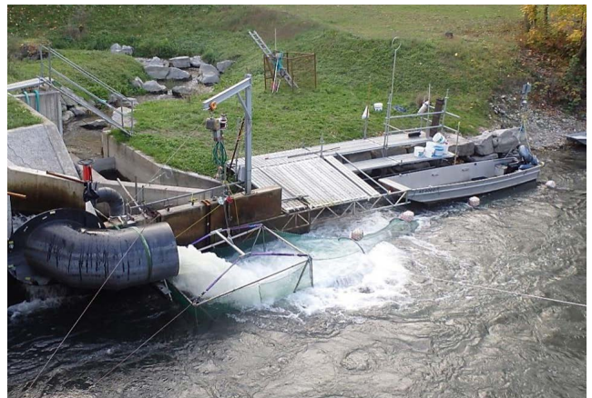
Fig. 82 : Mise en place de la nasse et d'une plate-forme pour le suivi biologique
