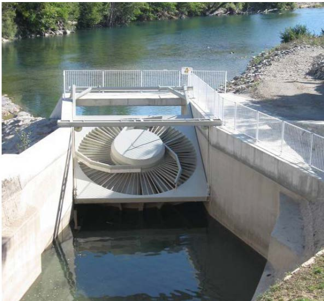
Fig. 41 : Turbine « very low head »
