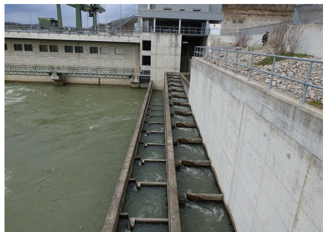
Fig. 58 : Passe à fentes verticales
