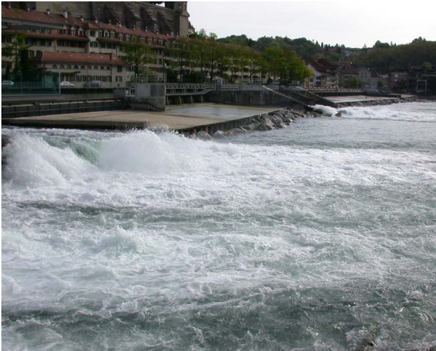
Fig. 63 : Barrage et bief aval
