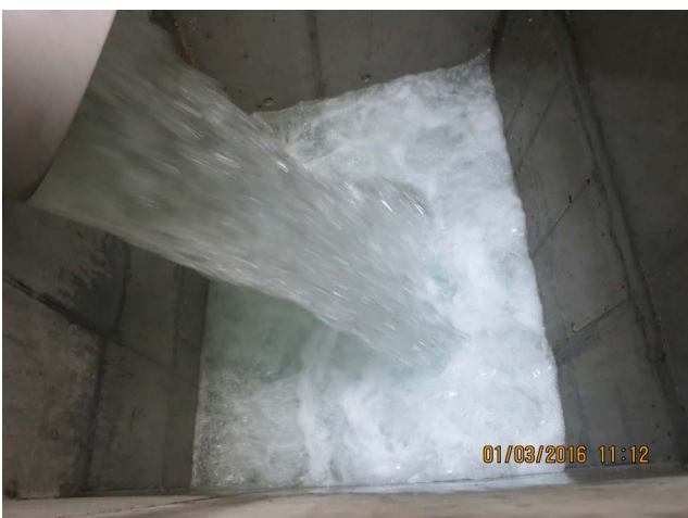
Fig. 88 : Chute dans le by-pass
