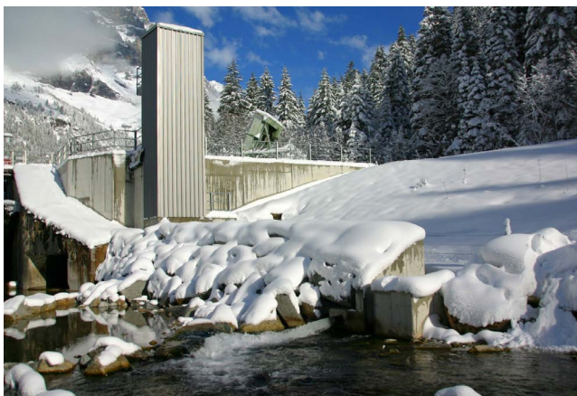
Fig. 70 : Ascenseur à poissons
