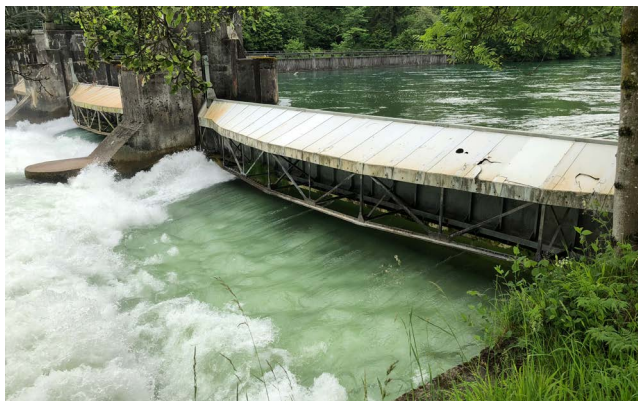
Fig. 45 : Vanne de barrage à sousverse
