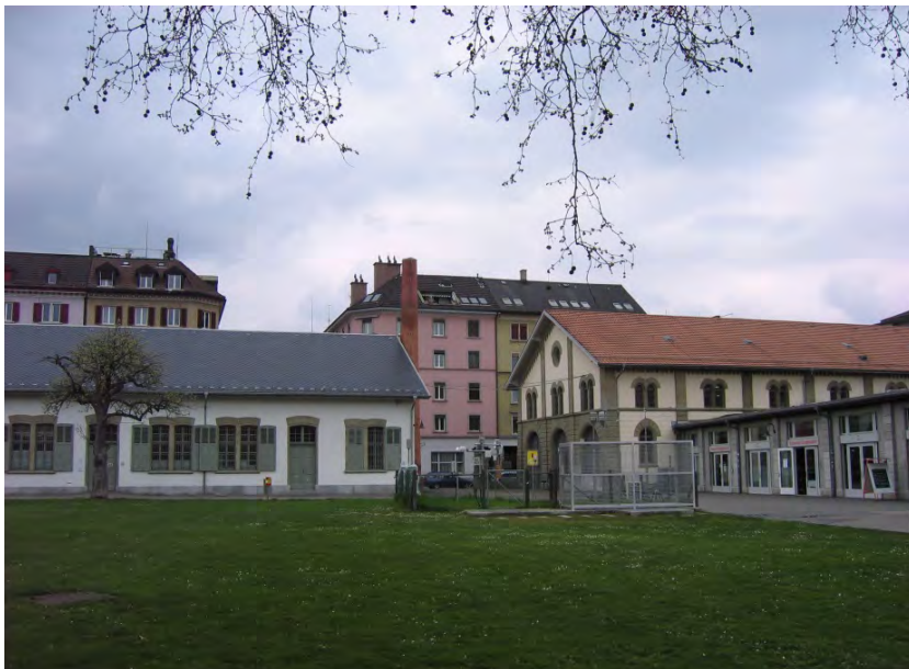
Abb. 2-43: Messstation Zürich, Zeughaushof
