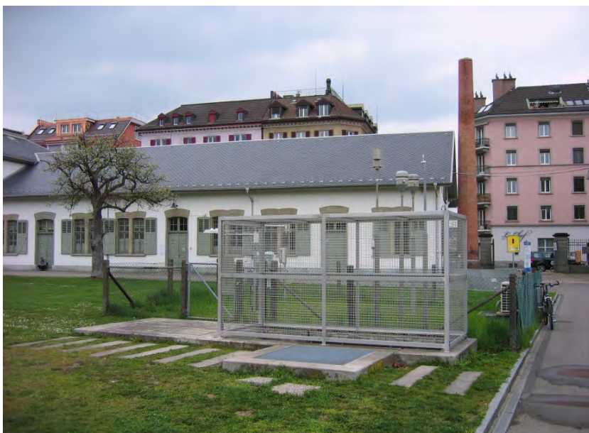
Abb. 2-44: Messstation Zürich (Messstation unterirdisch)
