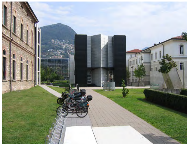
Abb. 2-25: 4 Standorte der Messstation Lugano Abb. 2-26: Messstation Lugano
