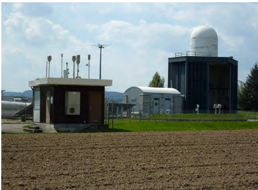
Abb. 2-32: Messstation Payerne, auf dem Gelände von MétéoSuisse Payerne
