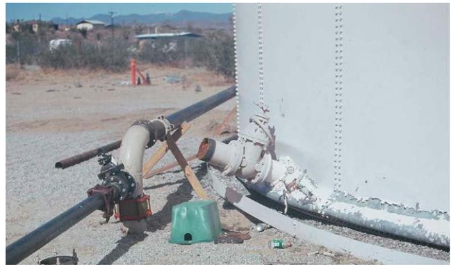
Rupture de la conduite d'alimentation due au soulèvement de la citerne causé par le mouvement du contenu liquide (dans ce cas une citerne d'eau)<sup>4</sup>
