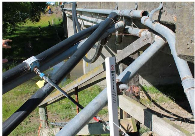
Réparation provisoire d'une conduite d'eau rompue à la suite du tassement différentiel d'un pont (Kaikoura, 2016)<sup>10</sup>
