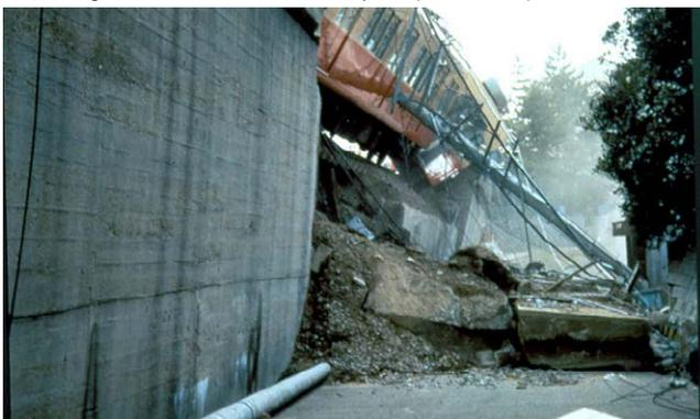
Effondrement d'un mur de soutènement (Kobe, 1995)<sup>7</sup>
