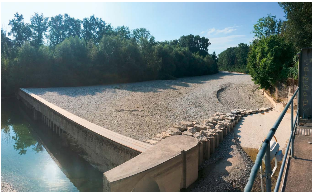
Fig. 28: L'Emme presso il punto di captazione dell'acqua di Schalunen per la centrale elettrica Hagerhüsli di Bätterkinden, BE, 20 luglio 2018
