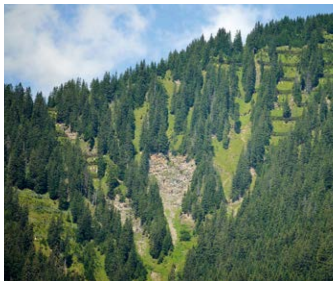
Fig. 5.2.1 Bosco di protezione presso Adelboden (BE). L'azione protettiva del bosco è stata completata con ponti da neve d'acciaio (in alto a destra) e reti d'acciaio (in basso a sinistra). Foto: Peter Brang
